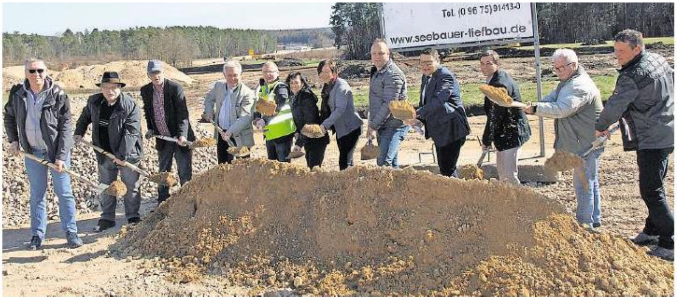
Mit zahlreichen Spaten wurde bei herrlichem Frühlingswetter der offizielle Spatenstich für das neue gemeindeeigene Wohnbaugelbiet Wackersdorf-Süd Bauabschnitt III vorgenommen. FOTO: SJJ
